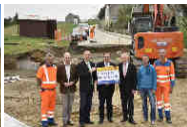
Ausbau B35 Obernalb-Retz
