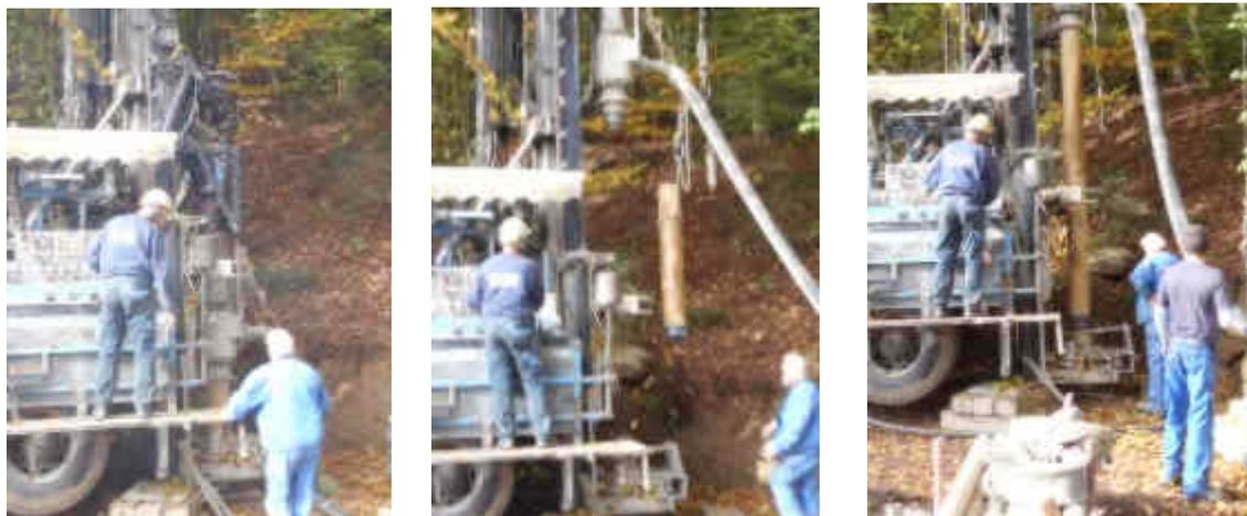
Bohrstange um Bohrstange, Brunnenrohr um Brunnenrohr wird in die Erde getrieben. Un-
